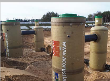
Индустриальный парк "Великий камень" "Оборудование для очистки поверхностного стока в составе ЛОС накопительного типа с самым большим в мире безбетонным аккумулярующим резервуаром АСО StormBrixx, Минск, Республика Беларусь
