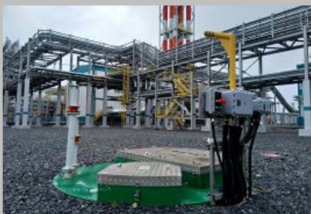
Производство и поставка 30-и комплектных КНС ПАО "СИБУР Холдинг" Западно- Сибирский Нефтехимический комбинат Г. Тобольск
