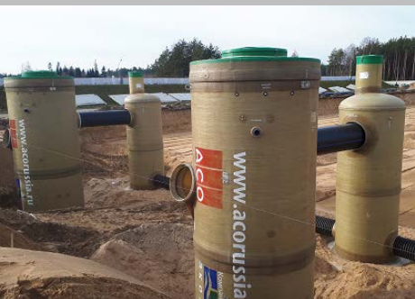
Индустриальный парк "Великий камень" "Оборудование для очистки поверхностного стока в составе ЛОС накопительного типа с самым большим в мире безбетонным аккумулирующим резервуаром АСО StormBrixx, Минск, Республика Беларусь
